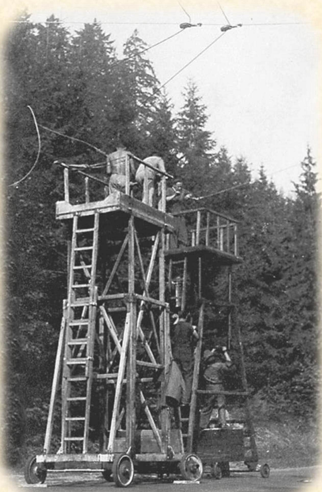
Obě dřevěné montážní věže při stavbě trolejového vedení u Lesního pramene.
