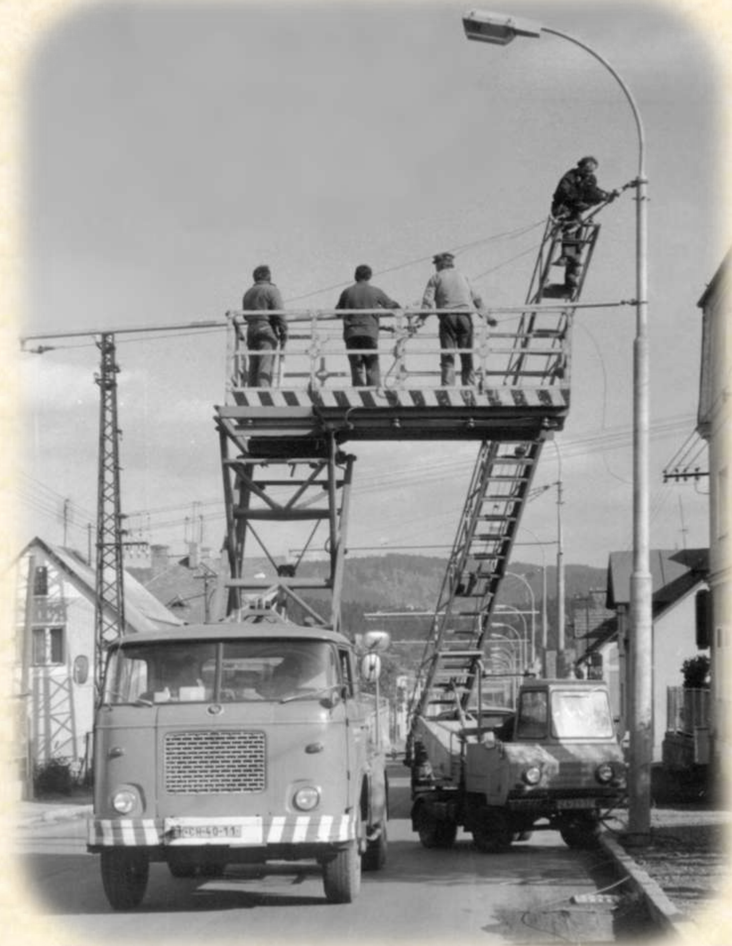
Pro výstavbu a údržbu trolejového vedení se používaly nejen montážní plošiny (zde Škoda 706 RTH – vpravo), ale i výsuvný žebřík Multicar M24 (vlevo). Snímek ze stavby trolejbusové trati ve Velké Hleďsebi.
