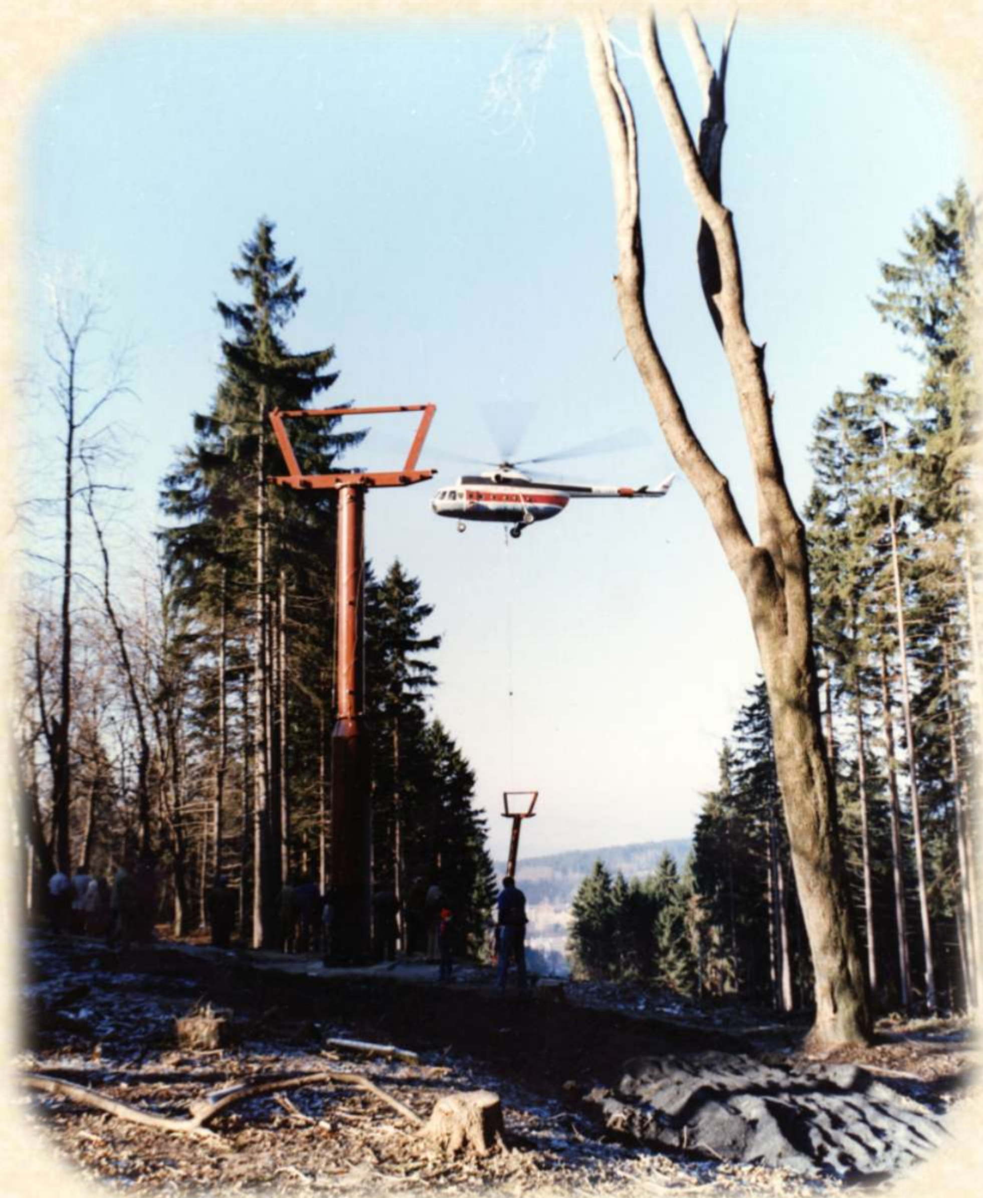
Při výstavbě podpěr lanové dráhy byl nápomocen vrtulník.
