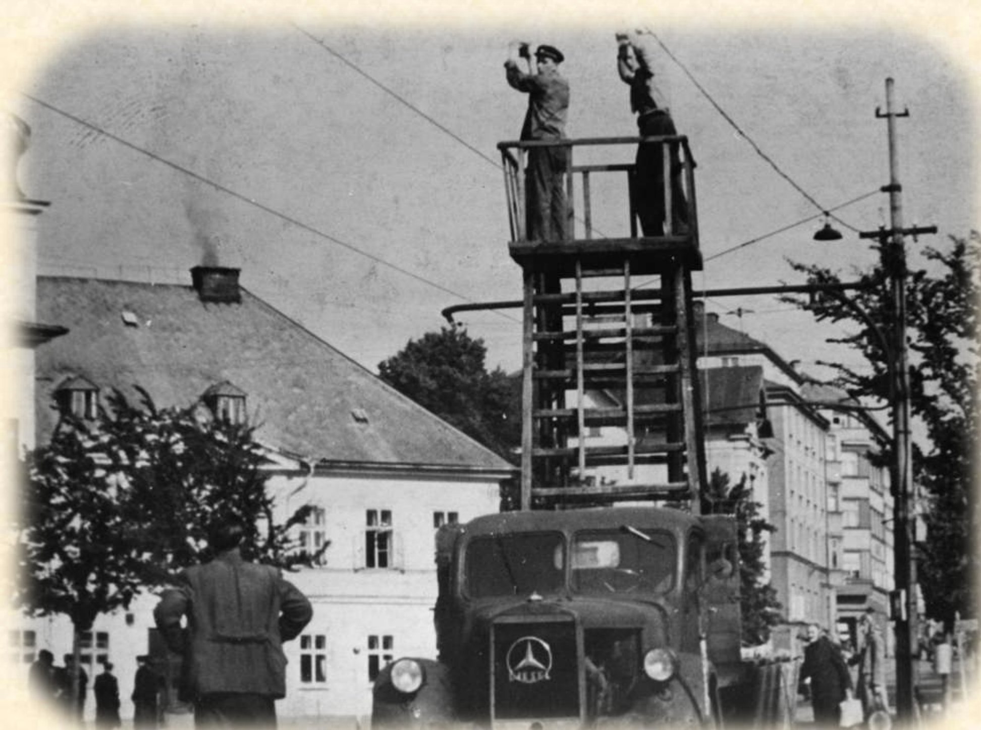
Výstavba trolejbusového vedení před Šumavou (Chebská křižovatka).
